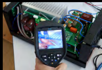
Wärmebildkamera zur Überwachung
